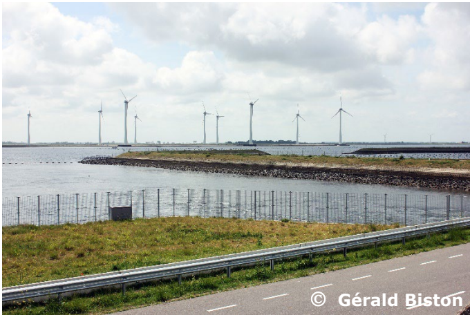
Nouveau sas supplémentaire de Bruinisse
