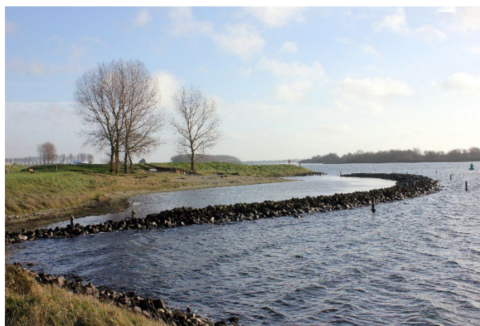
Mise à l'eau à Geersdijk
